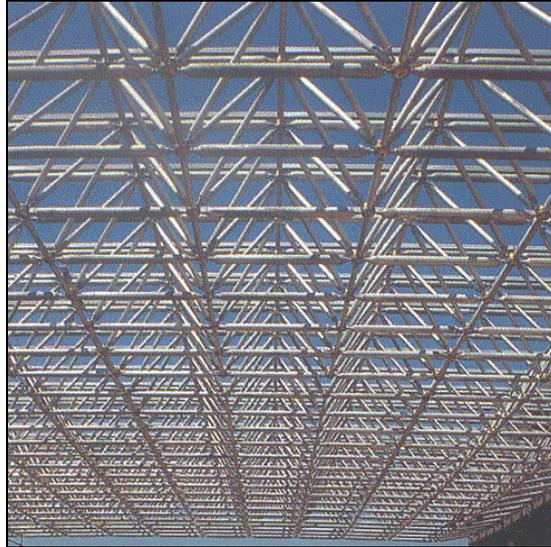
**Figura 6.** Esempio di struttura reticolare per copertura.
